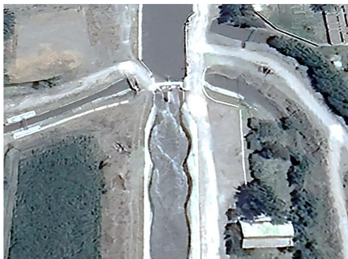
Рис. 1. Головное сооружение канала Янги Даргом
